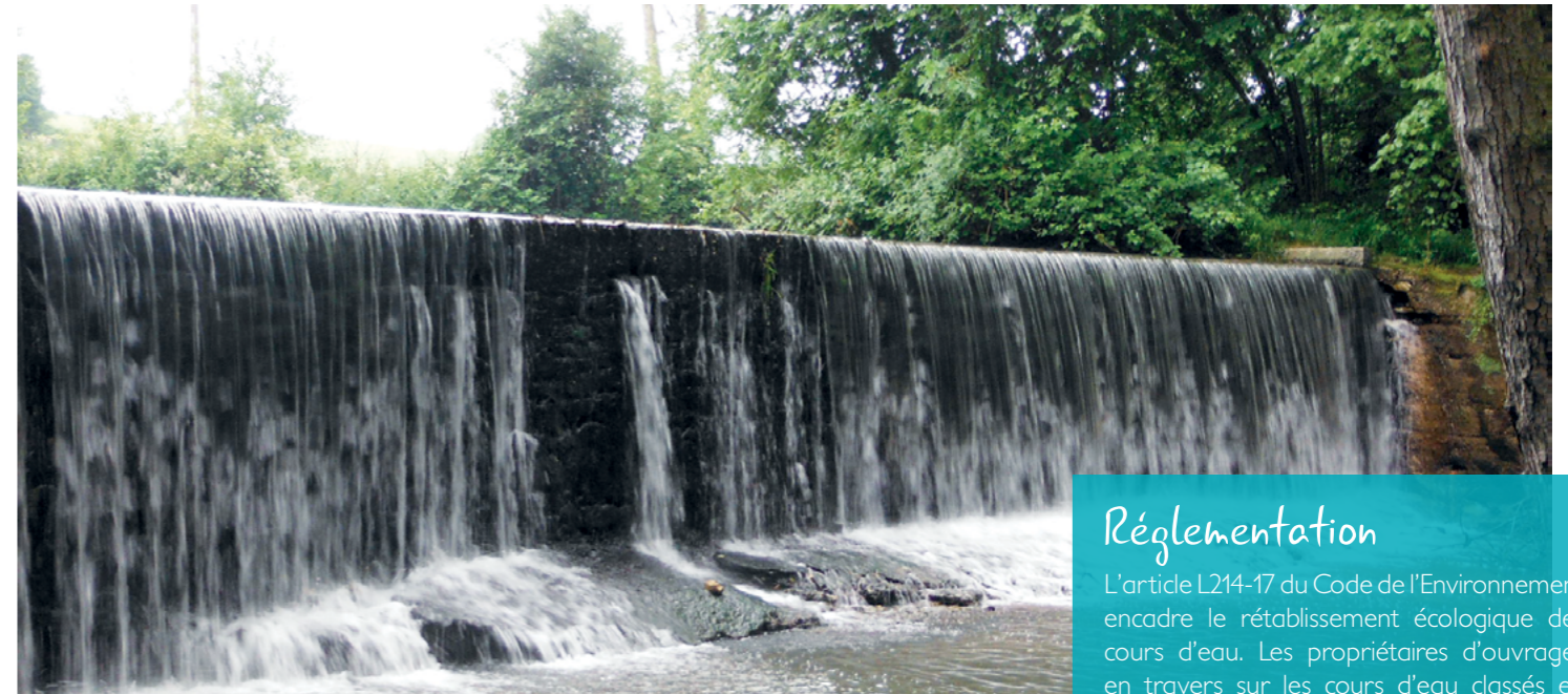
Seuil du Moulin de la Teyssonne situé à Briennon
