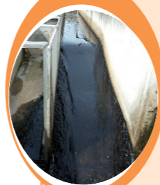
Canal de sortie
