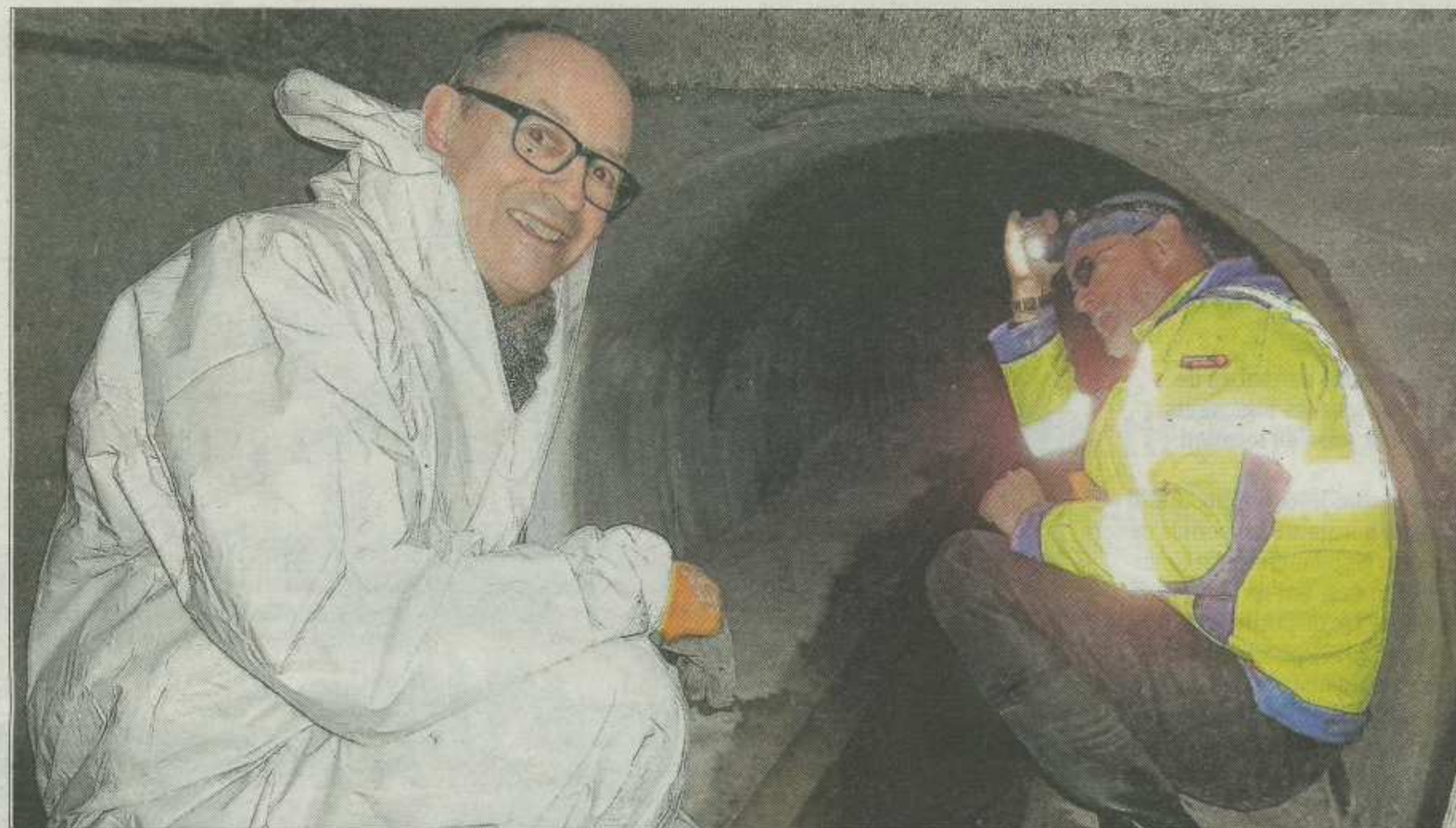
Président de la Roannaise de l'eau, Daniel Fréchet (en blanc) est descendu dans l'ancien réseau pour voir les travaux effectués. Photo Alexandre PETETOT
