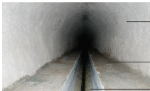
Aperçu du rendu final après travaux
