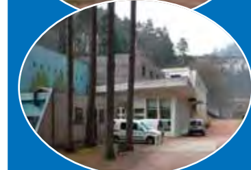
Usine actuelle située au pied du barrage du Chartrain
