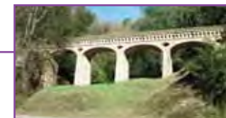
Conduite à écoulement libre actuelle
